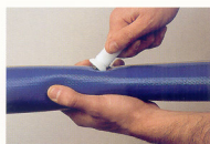
εύκολη τοποθέτηση του βασικού κορμού στην οπή με τη βοήθεια κλειδιού τύπου allen
