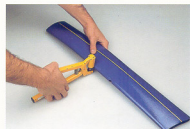
κοπή οπής πλευρικά για μονόπλευρο σύστημα άρδευσης
